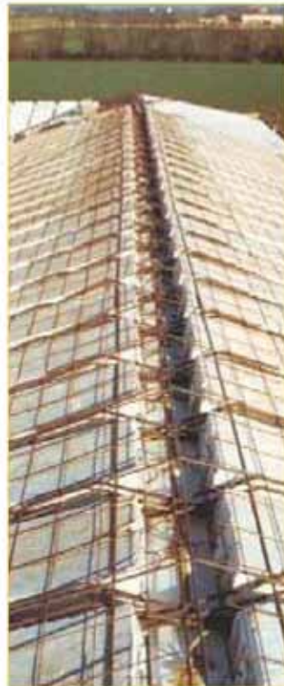
Roof System Ready to Pour
