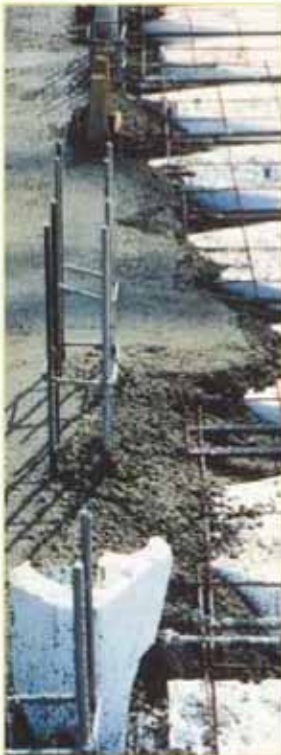
Pouring the Floor
